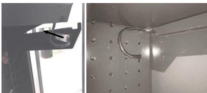
Abb. 9: Kabel LED-Balken verlegen
